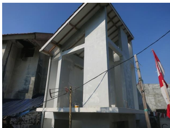
チキニーにUI と共同で建設中の建物（図書館）
